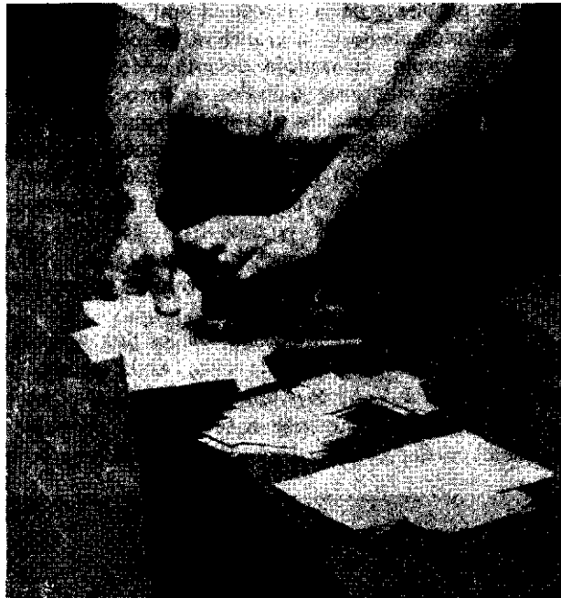
Figura 4. Fase del engrapado en la operación de ensamble de las protecciones (por cortesía de la General Motors de Brasil).
